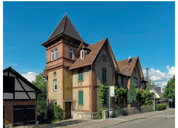
1888 | Turmaufbau 1899 Wohnhaus | „Villa Hämmerle“ Erbstetter Straße 38 Architekt: Oberamtsbaumeister Christian Hämmerle, Backnang
