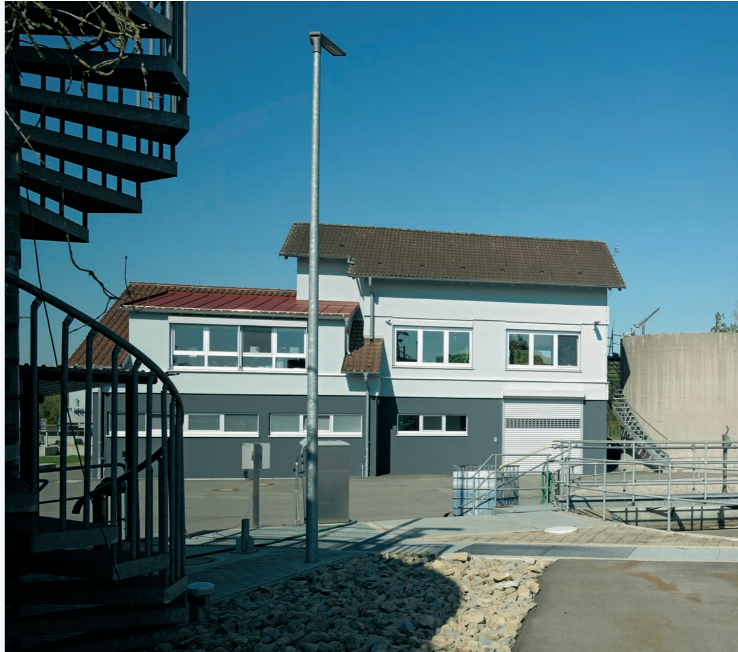
Betriebsgebäude der Kläranlage
