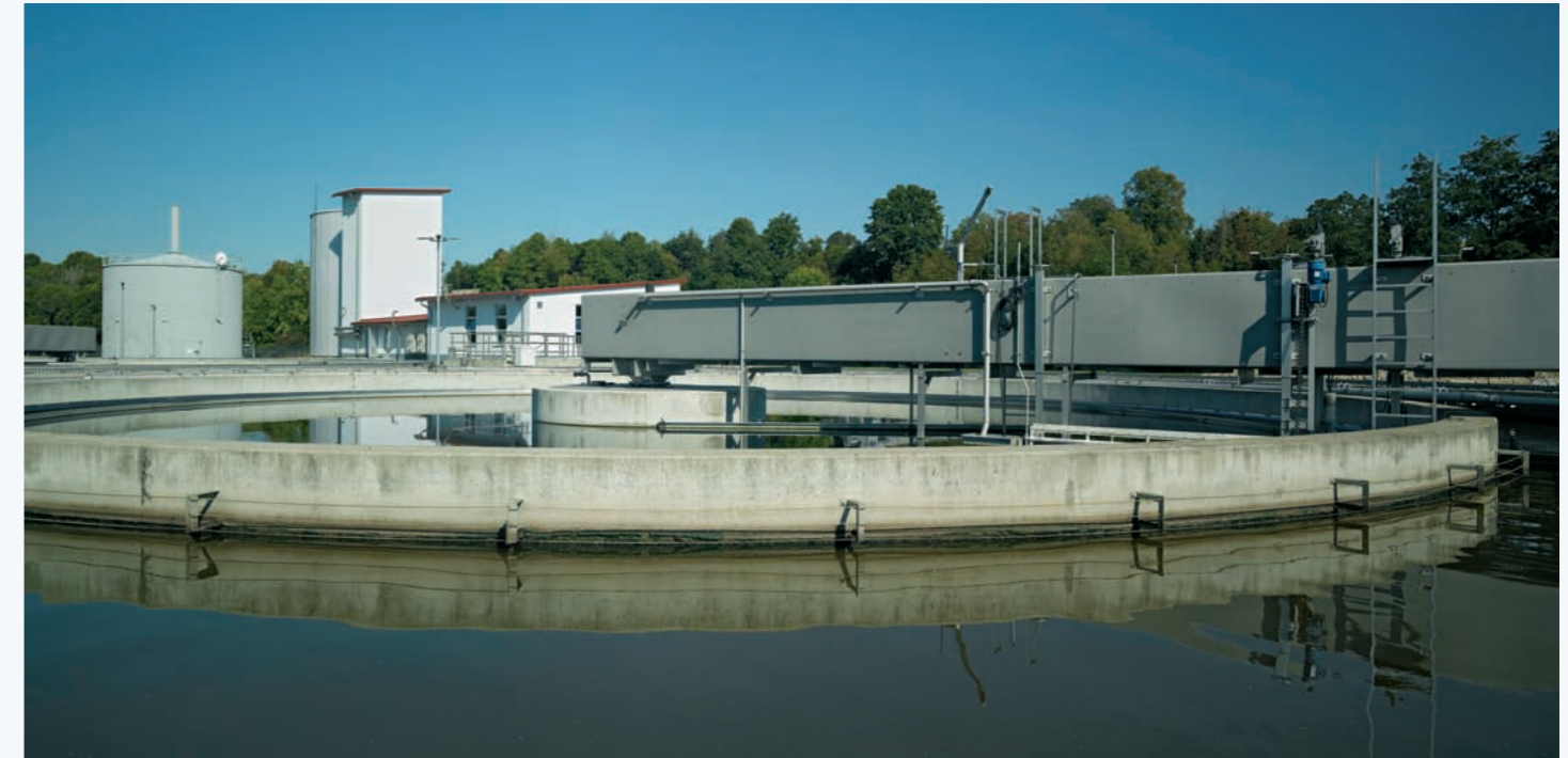
Kombibecken: außen Belebungsbecken, innen Nachklärung
